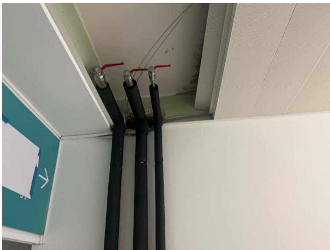
Obstoječi dvizni vod in odcepni ventili za hladno in toplo vodo ter cirkulacijo
