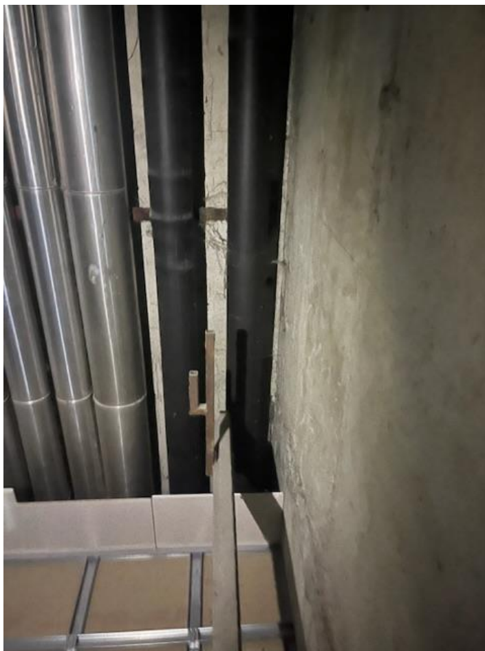
Obstoječi dvižni vod hlajenja v inštalcijskem jašku (podstrešje)
